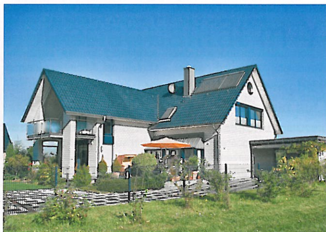
Nach wenigen Jahren drang Wasser im Keller des neuen Hauses wegen mangelhafter Außenabdichtung ungehindert ein.
